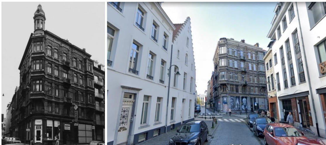
Etat de 1979 photo reprise à l'Inventaire du patrimoine architectural © Urban.brussels ; à droite, perspective vers l'immeuble depuis la rue du Vieux Marché aux Grains © Street View
