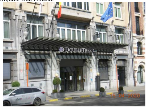
Enseigne projetée de l'entrée Rue Gineste
