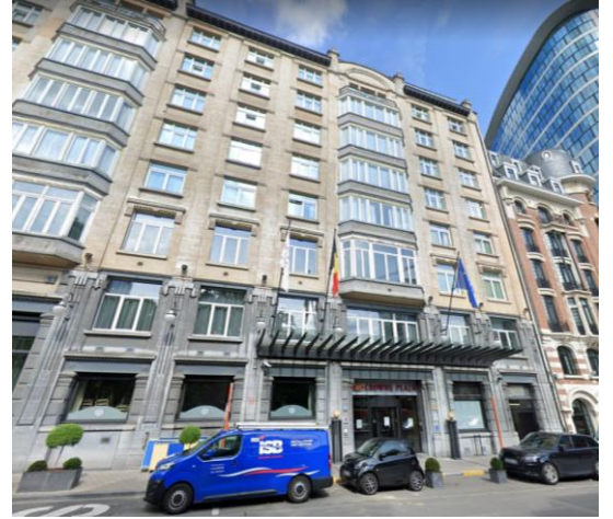
La façade actuelle Rue Gineste. ©Google Street View
