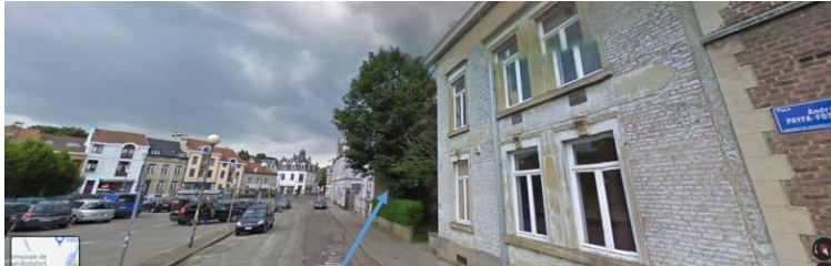
Pignon latéral droit qu'il est pas prévu d'isoler
