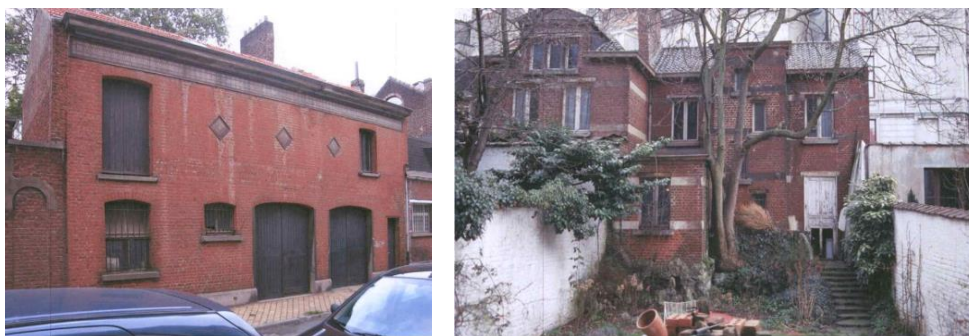
Vues actuelles des façades avant et arrière (extraits du dossier)
