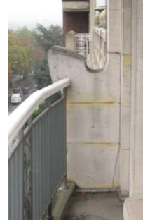
Garde-corps balcon 2 e étage – extrait du dossier de demande
