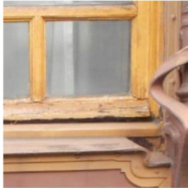
4 - détail de la fenêtre ouvrante: pièce d'appui déteriorée
