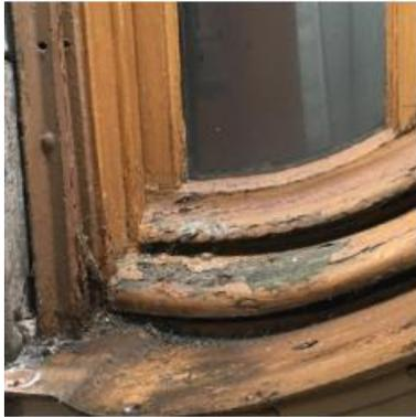
1 - détail de la fenêtre ouvrante: pièce d'appui déteriorée
