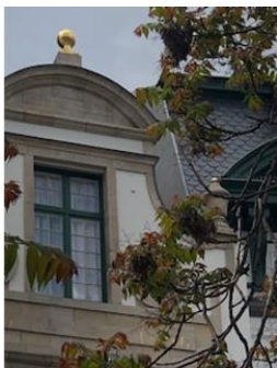
Zoom sur le pignon de gauche après travaux (avec isolation + enduit) – photo CRMS
