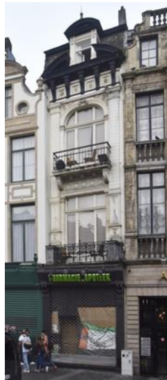
Etat avant travaux – extrait du dossier de demande
