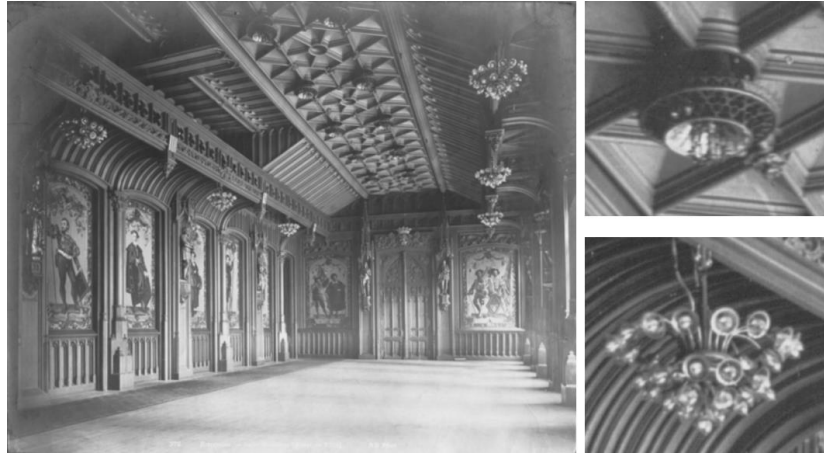
Photo de la salle gothique s.d. (entre 1880 et 1895), montrant la présence des sun burners fixés au plafond complétés de lustres
