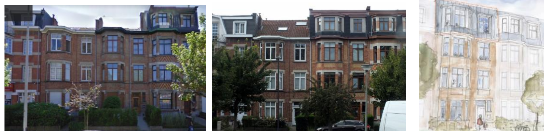
Situations mai 2009 (© Google map) et août 2021 (photo CRMS). A droite, situation projetée jointe à la demande
