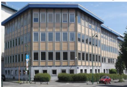
Bâtiment BAT existant à l'angle des rues Malis / Van Kalck. ©Google street view
