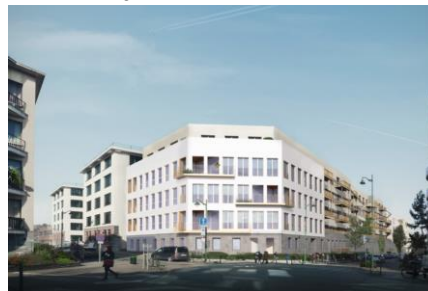
Bâtiment BAT rénové à l'angle des rues Malis / Van Kalck. Image extraite du dossier de demande
