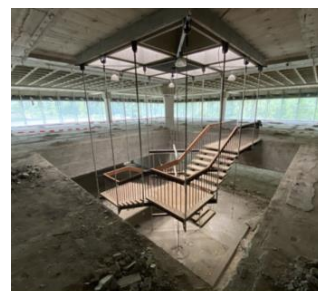
Escalier d'origine à démonter et réinstaller – photo extr. du dossier de demande
