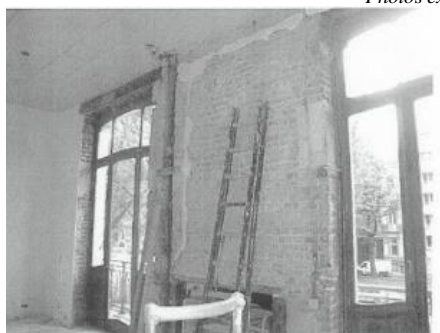
Situation pendant travaux.
