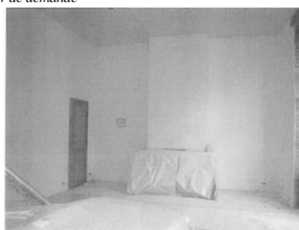
Situation après la réfection de l'enduit
