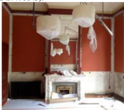
Situation après démontage des lambris.
