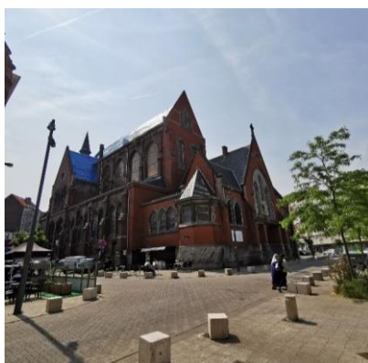
Vue extérieure de l'église. Photo CRMS
