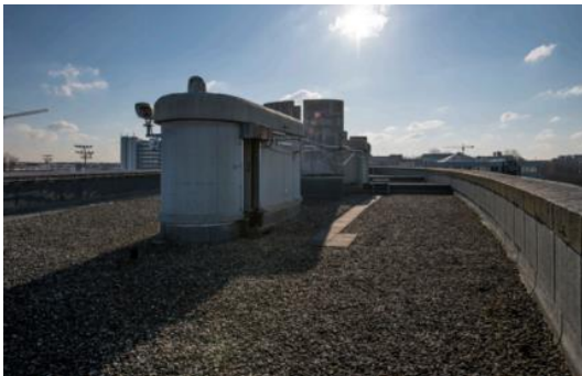
Zicht op het bestaande dak – foto uit het aanvraagdossier
