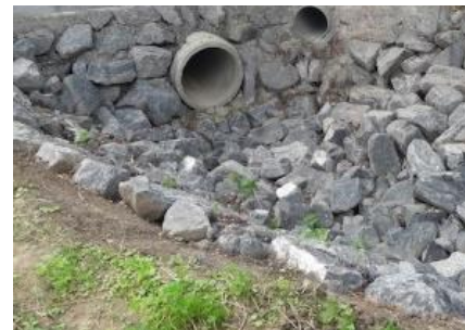
Illustration d'un enrochement en guise de tête d'aqueduc.
