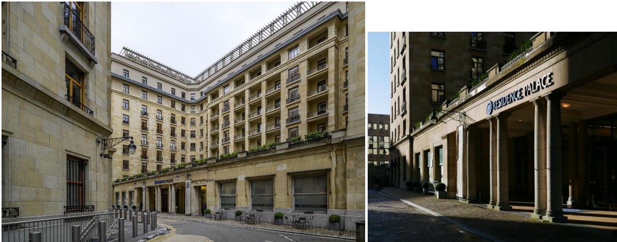
Entrée de l'IPC donnant sur la rue intérieure du Résidence Palace, photos jointes à la demande de principe
