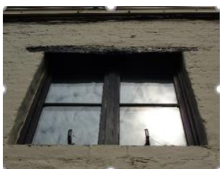
Châssis existants de l'étage en façade à rue
