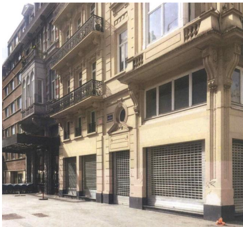
Vues sur la façade Rue Henri Maus
