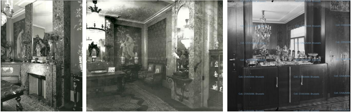
La richesse des décors intérieurs dans les années 30 : la cheminée du grand salon, le miroir encastré dans un des salons et un exemple de mobilier intégré (photographies de W. Kessel en 1932 - ©CIVA/AAM)
