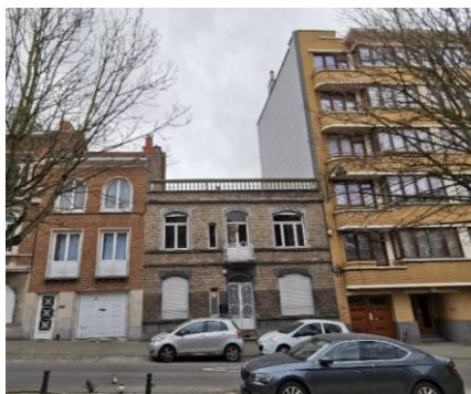
L'immeuble actuel. Photo CRMS
