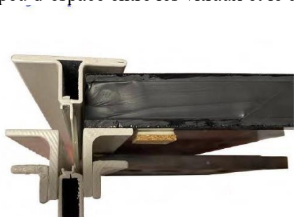
Echantillon de la structure en métal de la double peau de la loggia (vu de profil et de face), PV de réunion du 03/02/2022
