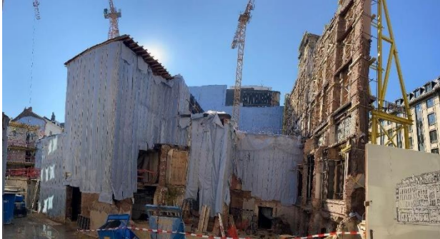
Vue panoramique de l'Astoria en chantier, photo DPC, 10/03/2022. A gauche, les pièces classées sous bâches et toitures provisoires. A droite la façade principale stabilisée.
