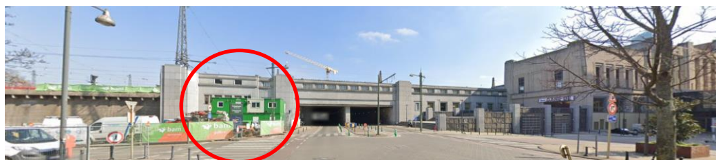
Vues 2009 et 2021 du tunnel de la Jonction nord-midi à hauteur de la place Solvay © Google maps
