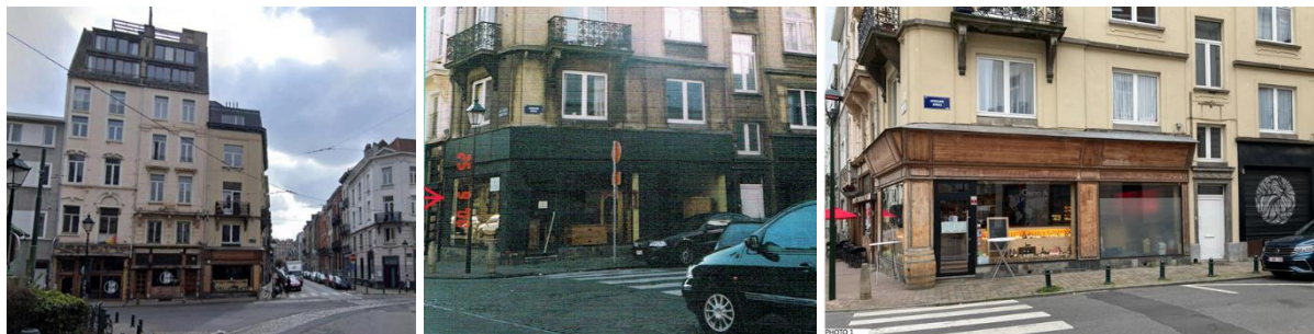
Vue l'immeuble d'angle concerné par la demande et son voisin de gauche, vue de la devanture au début des années 2000 et vue actuelle de la situation de fait (extr. du dossier de demande)
