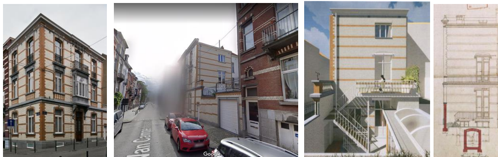
Bestaande toestand van de gevels (© Urban.brussels en Google Earth) ; fotomontage en archiefdocument gevoegd bij de aanvraag
