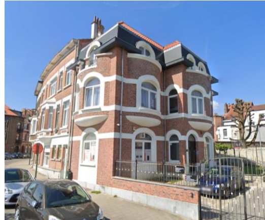
Vue du bien en 2022. Google Street View ©
