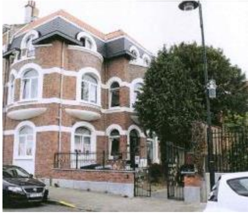
Vue du bien en 2019. Google Street View ©
