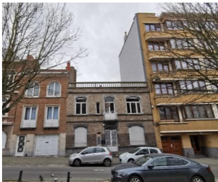
L'immeuble actuel. Photo CRMS
