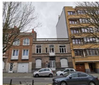
Le bâtiment prévu à la rehausse. Photo CRMS
