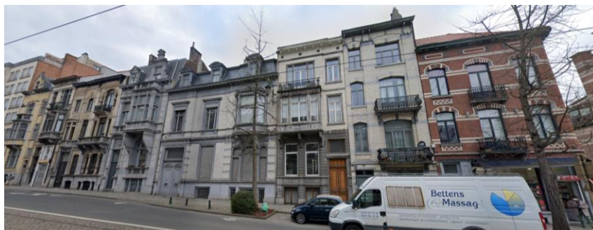
Vue de l'ensemble homogène formés par les immeubles n° 175 à 187 Images ©Google Street View
