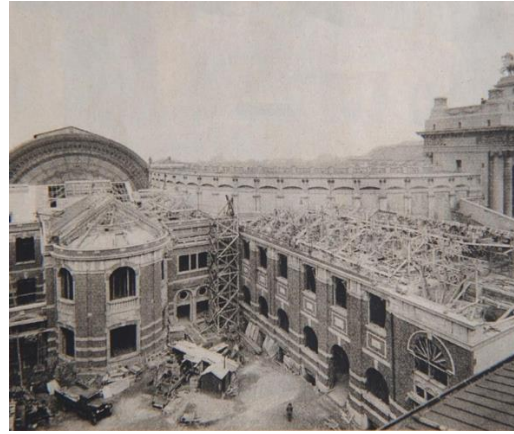
Les ailes autour du jardin japonais en construction, revue « Bâtir », 2, 1933, p. 54.
