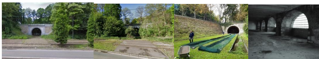
'Grand-Pont' état en 2013 et actuel, sortie du tunnel et cressonnière et vestiges de la gare ferroviaire souterraine © Streetview et (© Laca)
