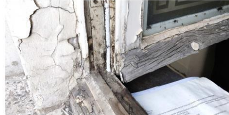
Photo de l'état actuel des châssis d'origine du 1 er étage. Image tirée du dossier de restauration
