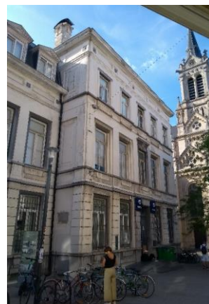
Vue depuis la Rue du Fort. Photo CRMS 2022
