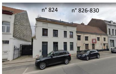
Etat de la façade, photo jointe à la demande
