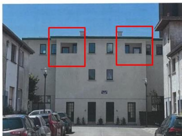
Types C rue de la Fondation 39 à 45
