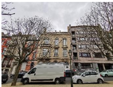
Vue sur le bien classé. Photo CRMS
