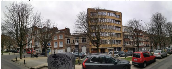
Vue panoramique de l'avenue du Roi avec le n°177 au centre. Photo CRMS.
