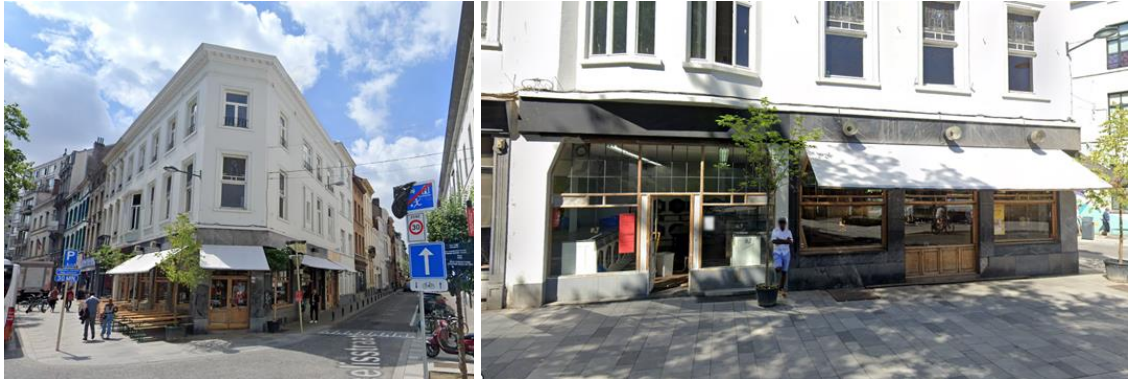
Vue d'ensemble et vue de la devanture en 2020 (©Google maps) : wasserette et Horeca
