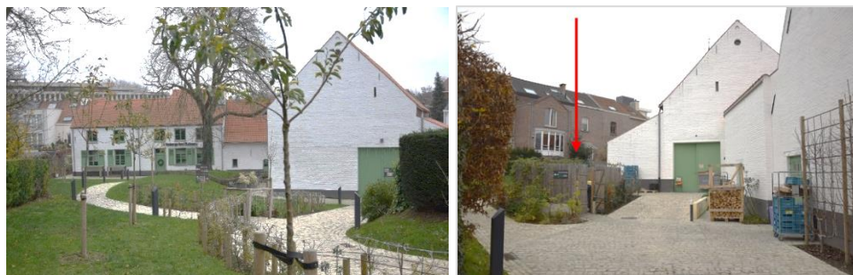
État de la ferme et enclos pour poubelles réalisé en infraction (photos CRMS, 2020)
