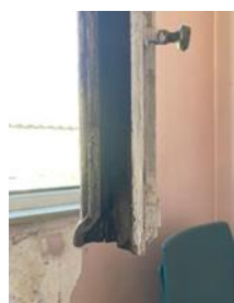
Etat vétuste des châssis et dessin des châssis projetés (extr. du dossier de demande)
