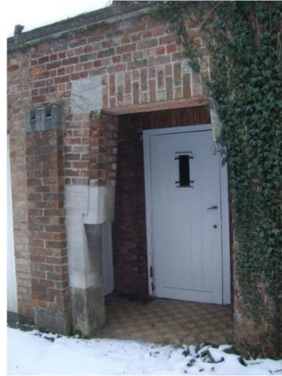
Façade nord-ouest, porche vers la buanderie (Photo E. Hennaut - L. Liesens /AAM, 2010)
