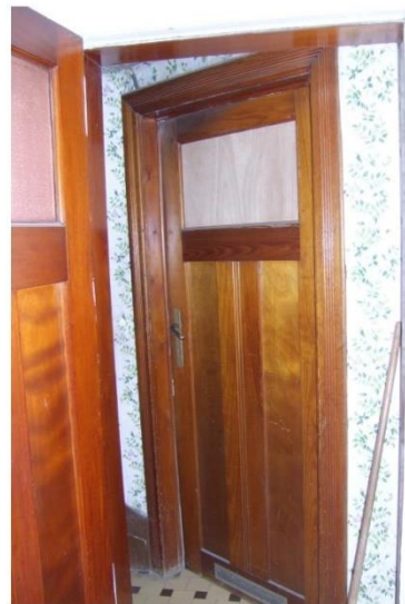
Etage, portes non peintes (Photo E. Hennaut - L. Liesens /AAM, 2010)
