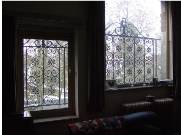
Étage, fenêtres de l'atelier (Photo E. Hennaut - L. Liesens /AAM, 2010)
