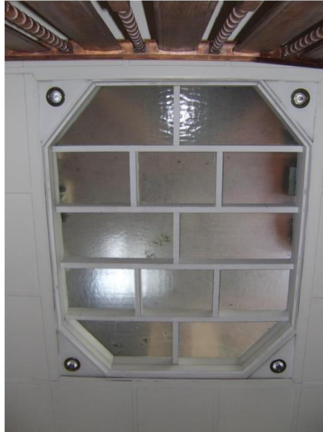
Hall, lanterneau (Photo E. Hennaut - L. Liesens /AAM, 2010)
