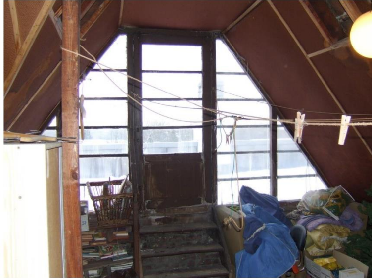
Combles, pignon vers le sud-est (Photo E. Hennaut - L. Liesens /AAM, 2010)
