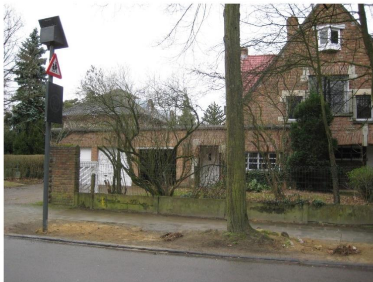
Façade nord-ouest, partie gauche (Photo E. Hennaut - L. Liesens /AAM, 2010)
