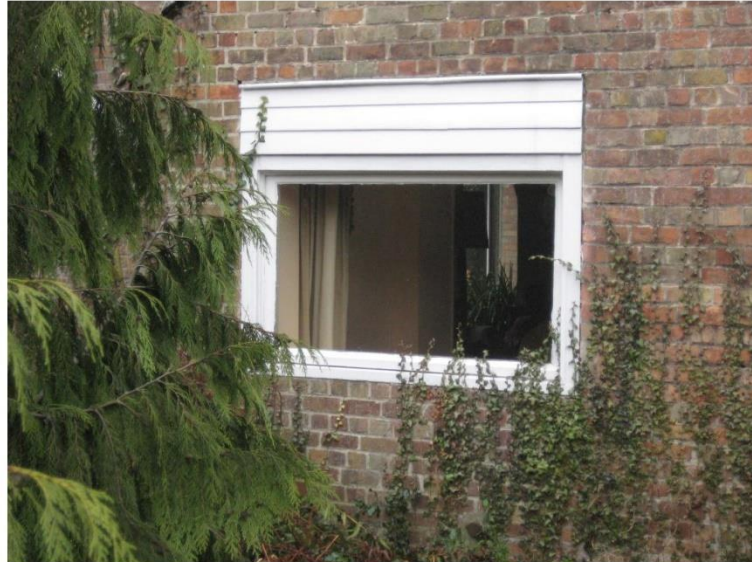
Façade latérale nord-est, fenêtre du rez-de-chaussée (salle à manger) (Photo E. Hennaut - L. Liesens /AAM, 2010)
