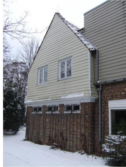
Façade latérale sud-ouest, pignon (Photo E. Hennaut - L. Liesens /AAM, 2010)
