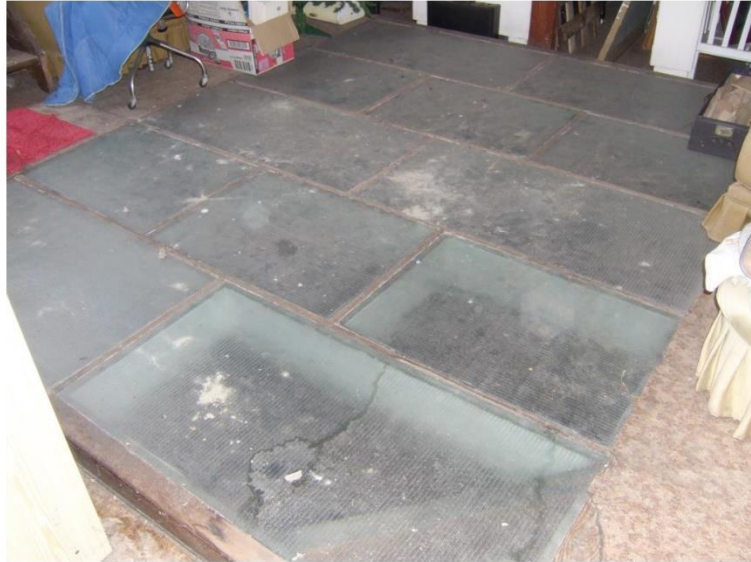
Comble, lanterneau au dessus du hall (Photo E. Hennaut - L. Liesens /AAM, 2010)
