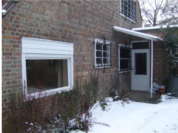
Façade latérale nord-est, rez-de-chaussée (Photo E. Hennaut - L. Liesens /AAM, 2010)
