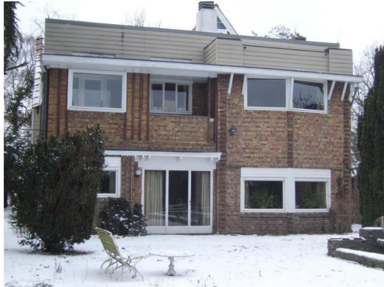
Façade arrière sud-est (Photo E. Hennaut - L. Liesens /AAM, 2010)
