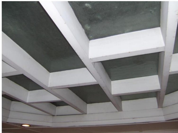
Hall, lanterneau, détail (Photo E. Hennaut - L. Liesens /AAM, 2010)
