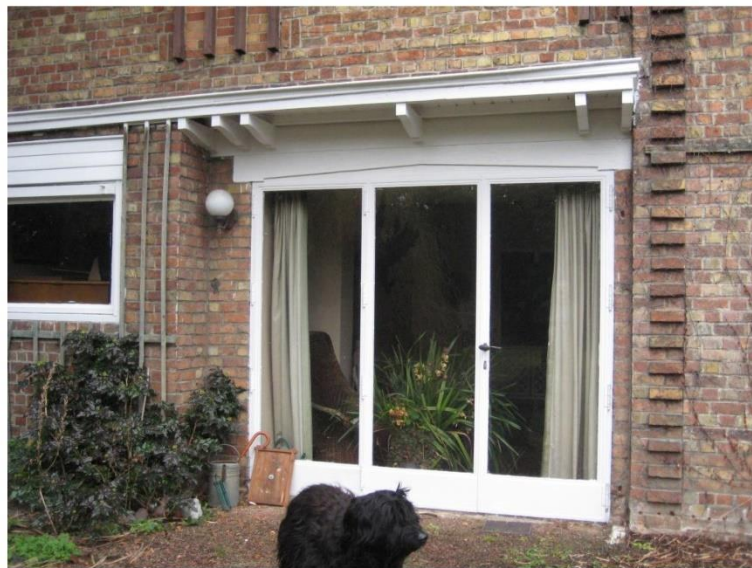
Façade arrière sud-est, porte centrale (Photo E. Hennaut - L. Liesens /AAM, 2010)
