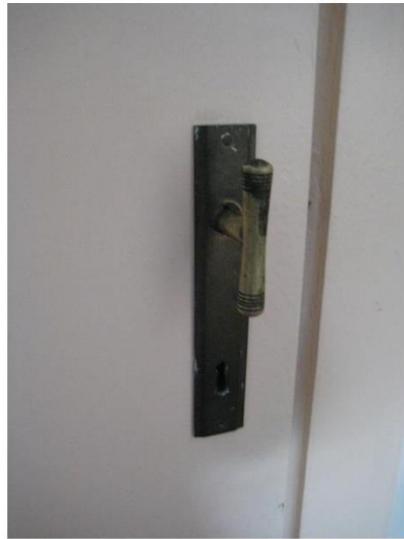
Rez-de-chaussée, salle à manger, détail d'une poignée de porte (Photo E. Hennaut - L. Liesens /AAM, 2010)
