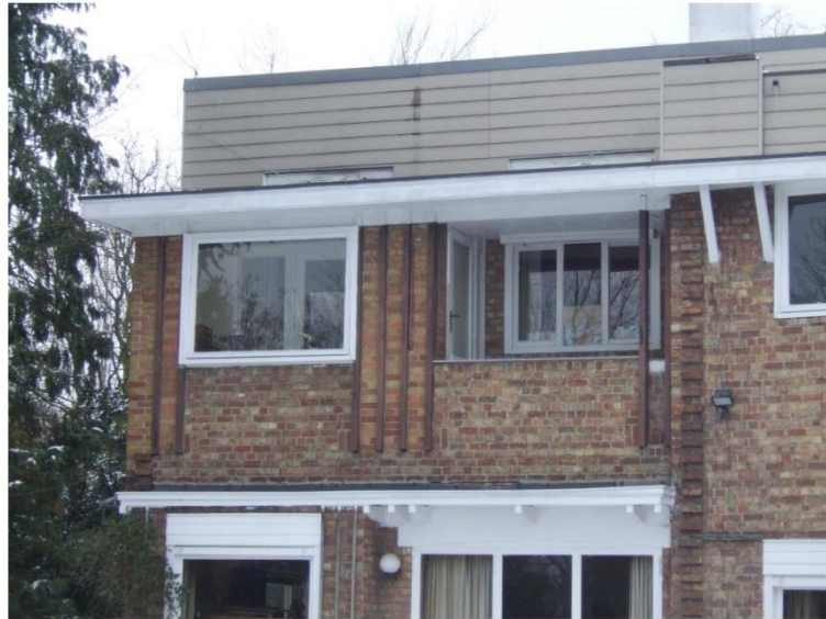
Façade arrière sud-est, étage, détail de l'ancienne terrasse (Photo E. Hennaut - L. Liesens /AAM, 2010)
