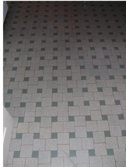
Rez-de-chaussée, cuisine, sol (Photo E. Hennaut - L. Liesens /AAM, 2010)
