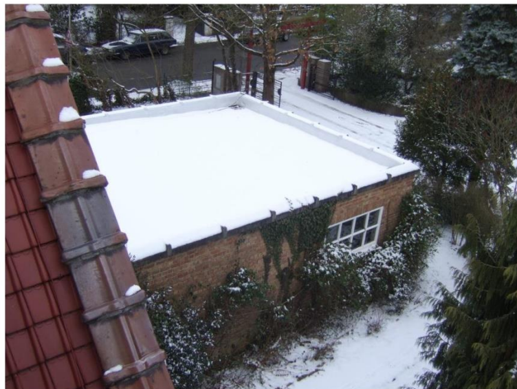
Façade latérale nord-est, vue sur les garages (Photo E. Hennaut - L. Liesens /AAM, 2010)
