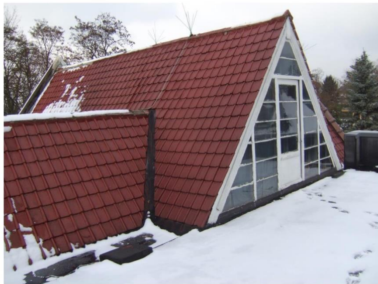
Toitures, pignon vers le sud-est (Photo E. Hennaut - L. Liesens /AAM, 2010)
