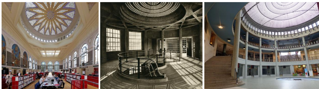
A g. : Toulouse, Bibliothèque du Périgord, 1928-35, arch. J. Montariol (©Journal Toulousain) Au centre : Paris, Lycée Camille-Sée, rotonde de l'entrée (extr. https://expositions-virtuelles.citedelarchitecture.fr/architecture_et_lumiere/02-PROJET-01-DOC-07.html ) A dr. : Bruxelles, Galerie Ravenstein, 1954-58 (©Urban.brussels)
