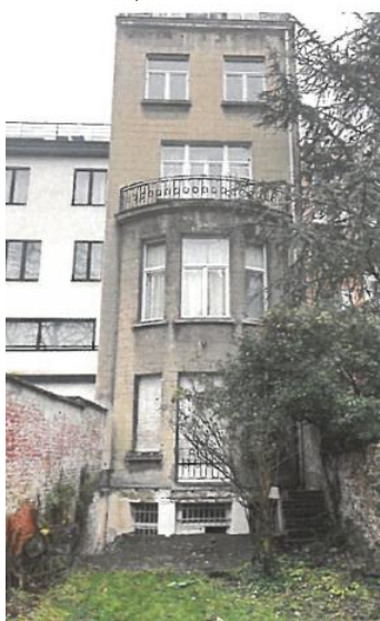
Photo de la façade arrière
