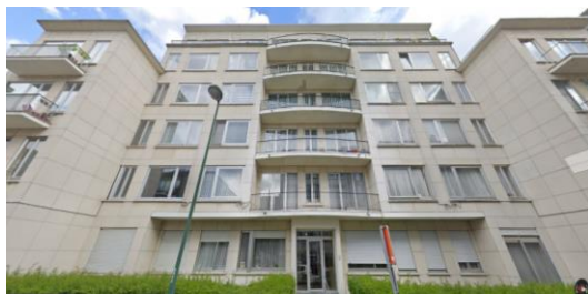
Photo de de l'immeuble. ©Google Street View
