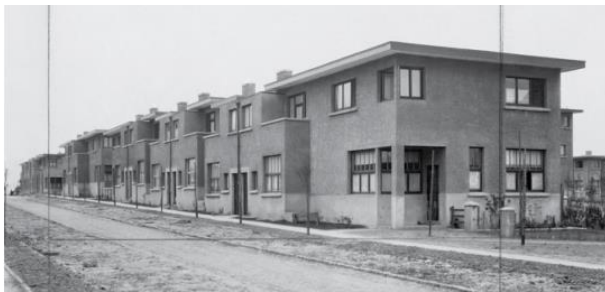
Rue de la cité Moderne - 1925. Typologies H et H' (angle). Sur cette photo on aperçoit clairement les bandes caractéristiques de la cité: Parterre engazonné de recul, trottoir de 90cm (3 dalles béton 30/30 + bordures minces en pierre ou béton) - bande engazonnée, bordure en moellons (pierre bleue ou porphyre) et la voirie pavée.
