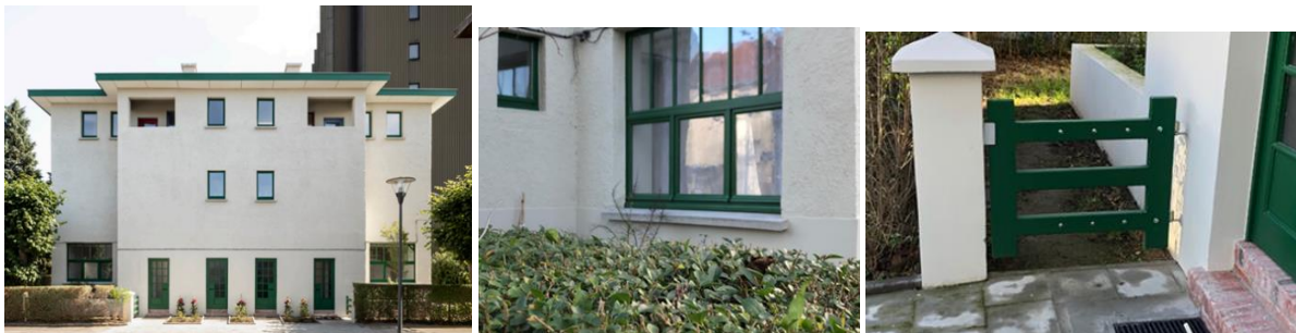
Rue de la Fondation, 39-45 : les Bovenhuis restaurées depuis 2022. Ce chantier récent a servi de « chantier-test » pour l'actuel projet de restauration-rénovation envisagé pour 173 logements. La visite organisée le 30/01/2023 par les auteurs de projet et les gestionnaires de la cité, en présence de la CRMS et de la DPC, a permis de voir ces immeubles rénovés. Vue de la façade (extr. du dossier de demande) et photos de détail (©CRMS)
