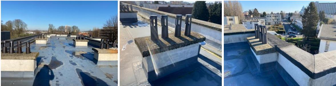
Vue de la toiture (Initiative, 1, 2 et 3), vue d'une cheminée à démolir et exemples de mitrons à démonter, dont le corps intérieur est démoli (extr. du dossier de demande)
