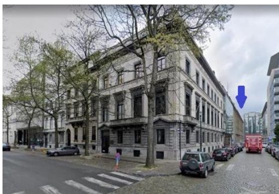
Vue sur les immeubles néoclassiques Rue Guimard depuis l'angle du Square Frère Orban. En bleu, l'immeuble sujet au projet. Image ©Google Street View, modifiée par CRMS
