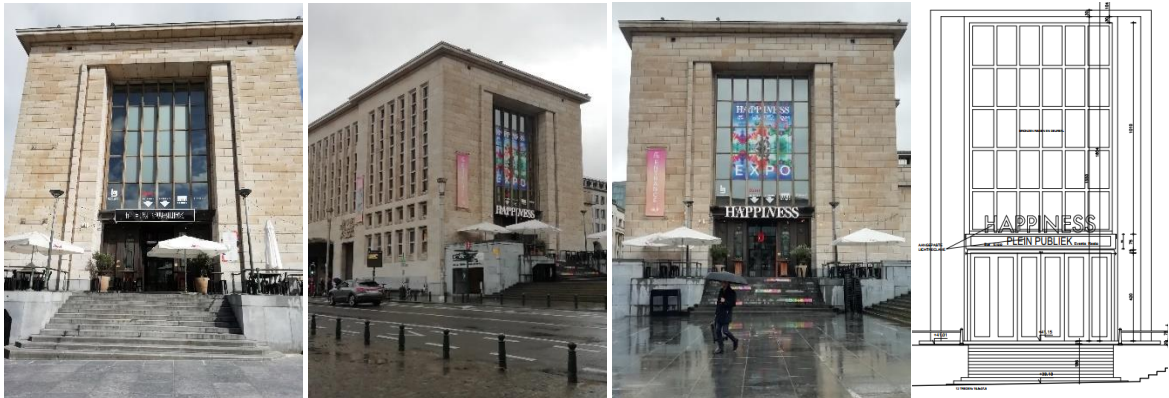
Gevel aan de zijde van het ruitersstandbeeld : van links naar rechts 'bestaande' toestand volgens de aanvraag, bestaande toestand sinds 29-03-2023 (foto's KCML) en ontwerp van de nieuwe lichtreclame gevoegd bij de aanvraag
