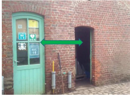
Placement d'une porte similaire.
