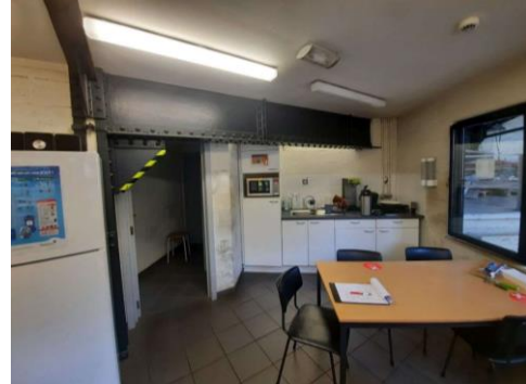
Intérieurs des locaux actuels. En arrière-plan, une des charpentes métalliques intégrées au bâti.
