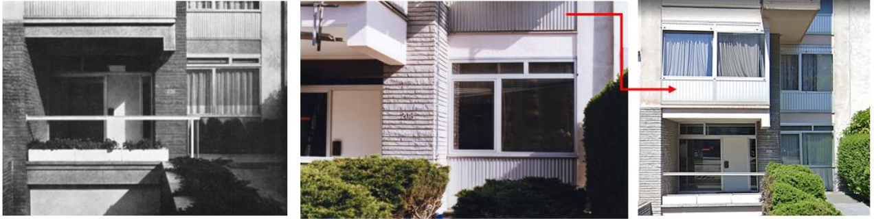
Détail des châssis et des allèges : état d'origine (Architecture 1963), état de 2005 (© urban.brussels) et situation existante (© Google Streetview) avec indication des nouvelles allèges
