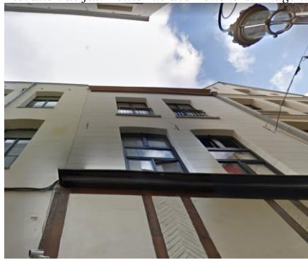
Photo des fenêtres aux étages du n°2 Petite Rue des Bouchers
