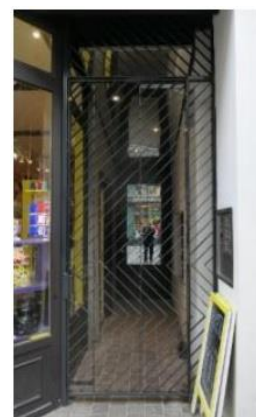
Photos de la grille d'accès aux logements au n°46. Photo : urban.brussels
