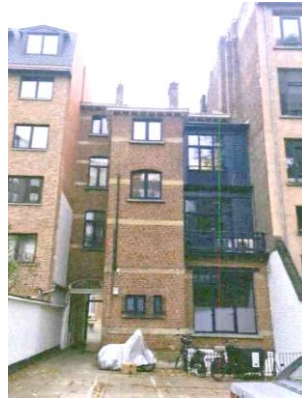
Façade arrière, état existant
