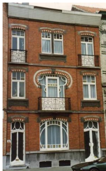
Vue de l'immeuble n° 8-10. Le n° 10 est la travée de gauche. Photo Google Street View©
