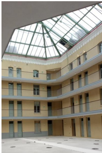
Situation existante du lanterneau et détail des grilles d'extraction (@urban.brussels)
